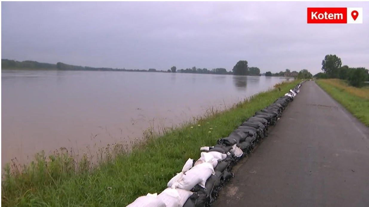
Figuur 4-7 Het plaatsen van zandzakken heeft instroming van Kotem in de nacht van 16 juli 2021 voorkomen. De volgende dag zakt het water al (bron: HLN, 2021)
