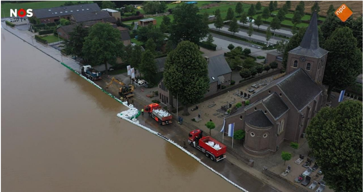
Figuur 4-12 Noodmaatregelen bij Heppeneert (rkm 50 links), bron: NOS, 2021
