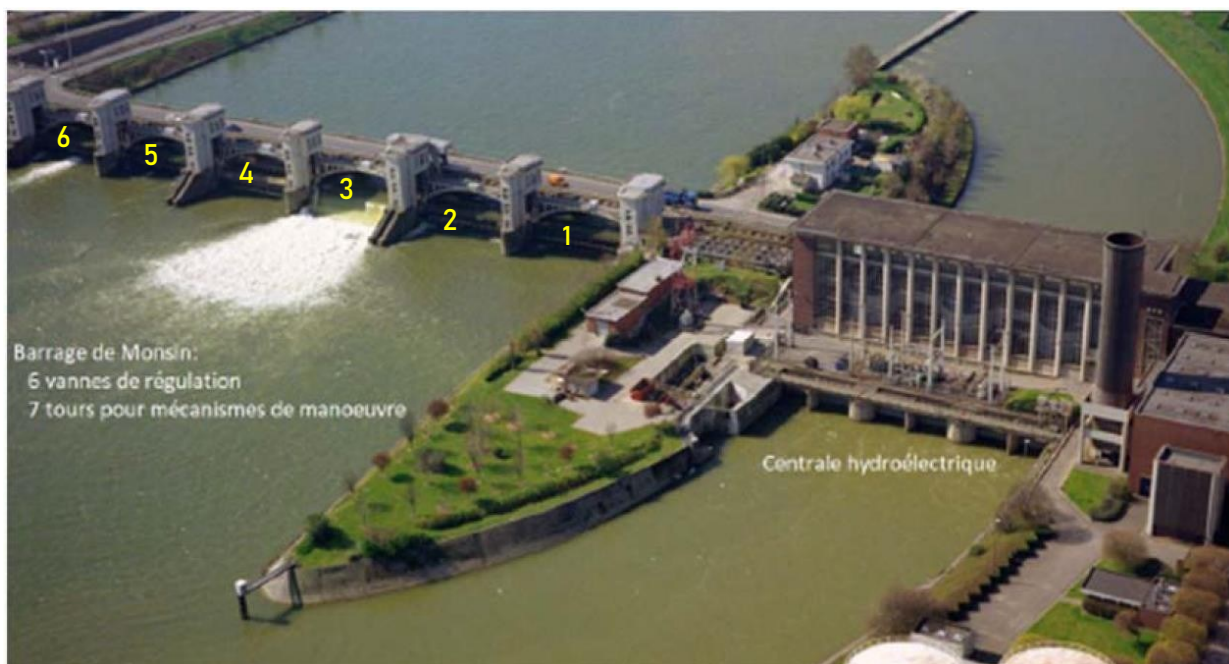
Figuur 3-1 Stuw Monsin en elektriciteitscentrale in normale bedrijfsstoestand (Zeimetz e.a., 2021)
