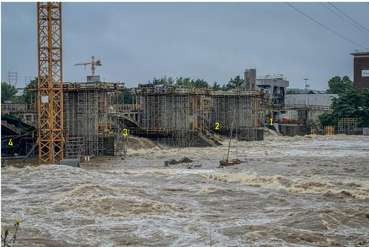
Figuur 3-2 De dam op 16 juli, met vier stuwdelen in de steigers (foto: Laura Hollange; bron: Het Belang van Limburg, 21 november 2021)
